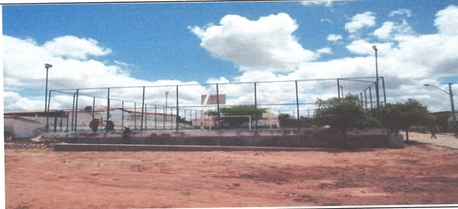
VISTA DA QUADRA
