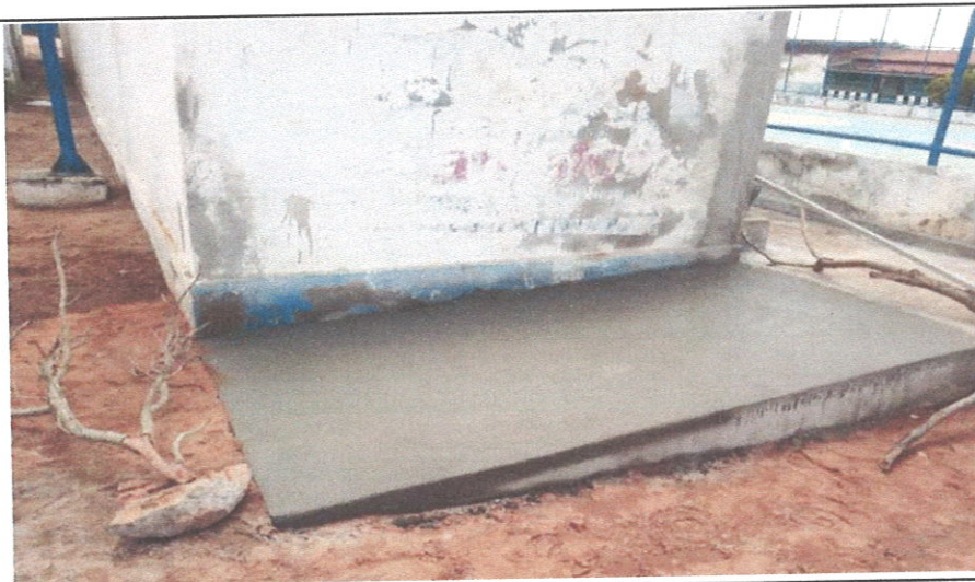
CONSTRUÇÃO DE RAMPA DE ACESSIBILIDADE
